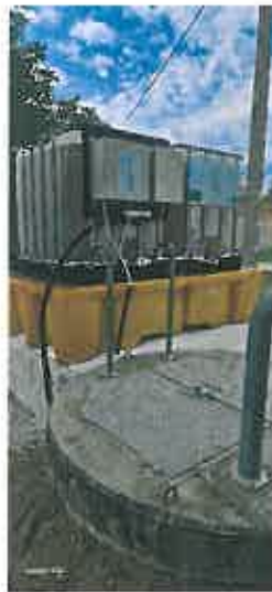
Vegyszeradagolás kiépítése Hántán a Kossuth u.-i átemelőnél
